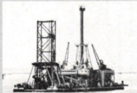
De vroegere drijvende asfaltfabriek Jan Heijmans werd omgebouwd tot grindstorters voor het nauwkeurig aanbrengen van grind en stenen in de drie meter brede voeg tussen twee fundatiematten.
