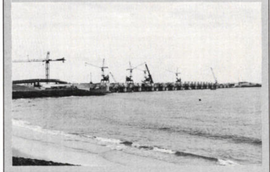
Onderstaande foto, gemaakt op 12 juli j.l., geeft een beeld van de bedrijvigheid in het sluitgat Hammen, waar men onder meer bezig is met de plaatsing van de opzetstukken. Momenteel zijn alle verkeerskokers reeds aangebracht en is het wachten op de plaatsing van de schuiven. Deze zullen in de periode tussen september 1984 en januari 1985 tussen de pijlers worden aangebracht door de Taklift 4, voordat een van de meest kritische fasen van de assemblage begint, te weten het plaatsen van de dorpelbalken (zie ook pag. 19). Voorlopig zullen de schuiven in de open stand worden vastgezet, totdat alle bewegingswerken zijn geïnstalleerd.
